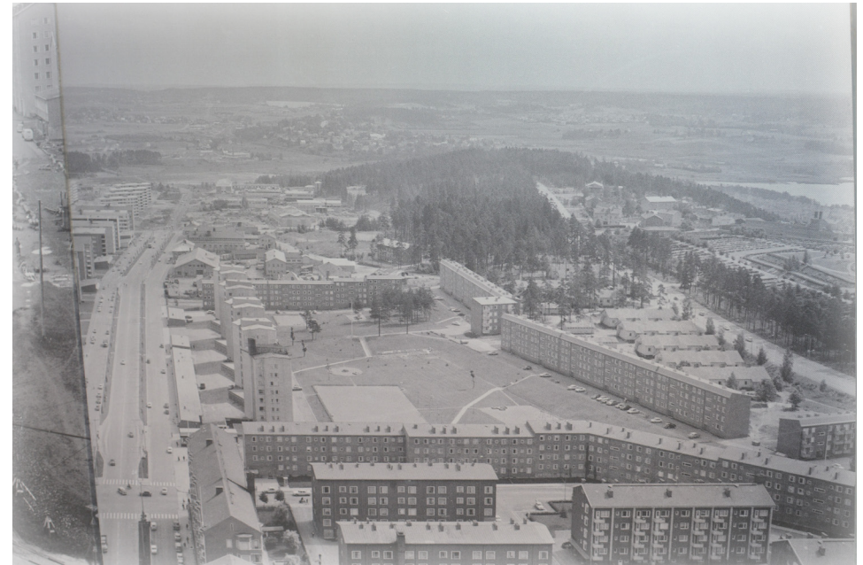
Kuva 5. Rakentuvaa Kalevan kaupunginosaa. Viljelys- ja harjumaiseman tilallisuus alkaa väistyä Kalevan kaupunginosan rakennustöiden edetessä. (Tampereen kaupunki)
